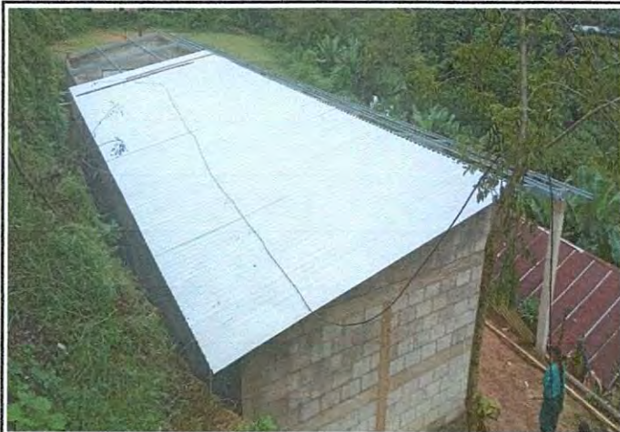
Foto 1: Mejoramiento al módulo de aula (estructura de techo con lámina troquelada calibre 26, piso cerámico, balcones, repación de repello y cernido de paredes)
