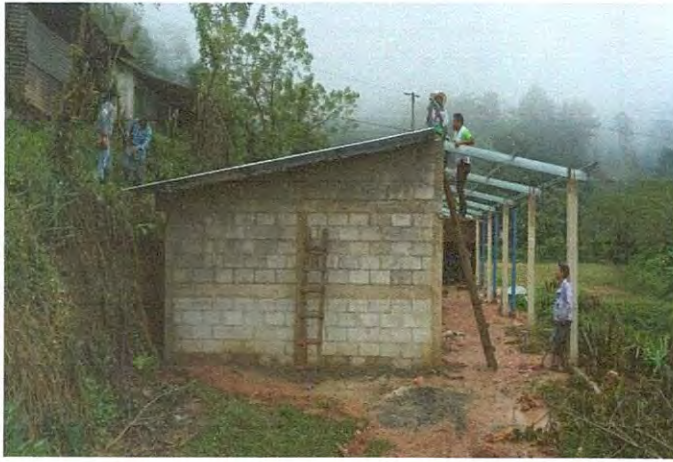
Foto1: Remodelación de aula tipo portico
