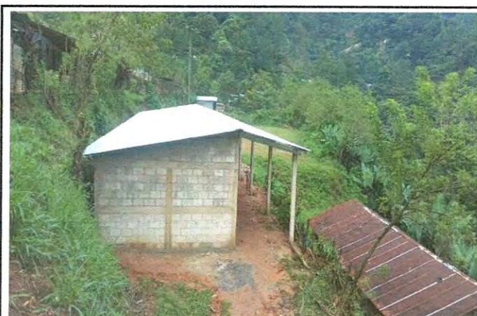
Foto 4: Mejoramiento al módulo de aula (estructura de techo con lámina troquelada calibre 26, piso cerámico, balcones, repación de repello y cernido de paredes)
