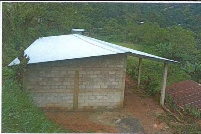
Foto 3: Remodelación de aula tipo portico
