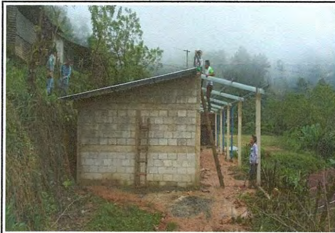
Foto 2: Mejoramiento al módulo de aula (estructura de techo con lámina troquelada calibre 26, piso cerámico, balcones, repación de repello y cernido de paredes)
