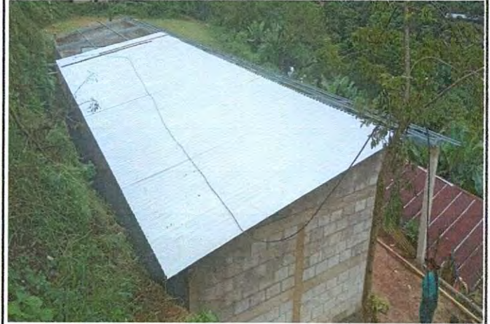
Foto 2: Remodelación de aula tipo portico
