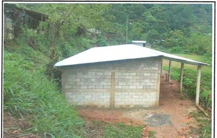
Foto 4: Remodelación de aula tipo portico
